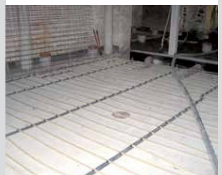
5 Roth Betonkerntemperierung Isocore® Rheinisches Landesmuseum, Bonn, Deutschland
