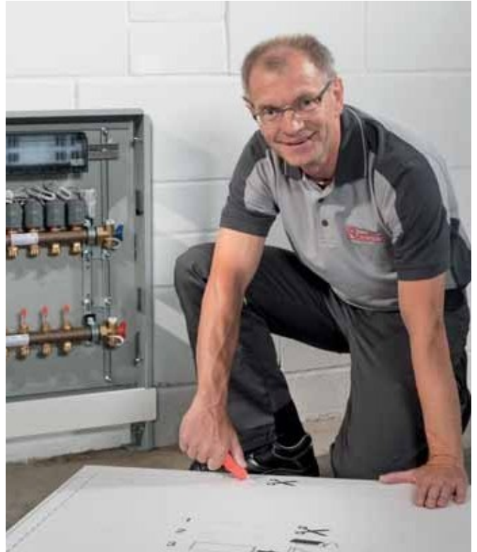
2. İnşaat aşamasında koruyucu şablonun kesilmesi.
