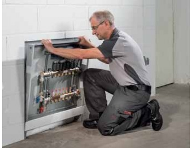
1. Fabrikada monte edilmiş dağıtım kabinini takın.
